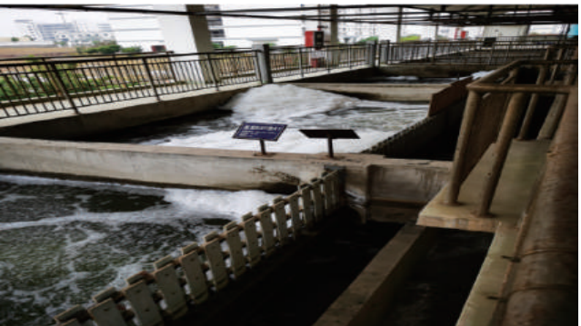
500吨每小时电镀污水项目 500 tons per hour electroplating sewage project
